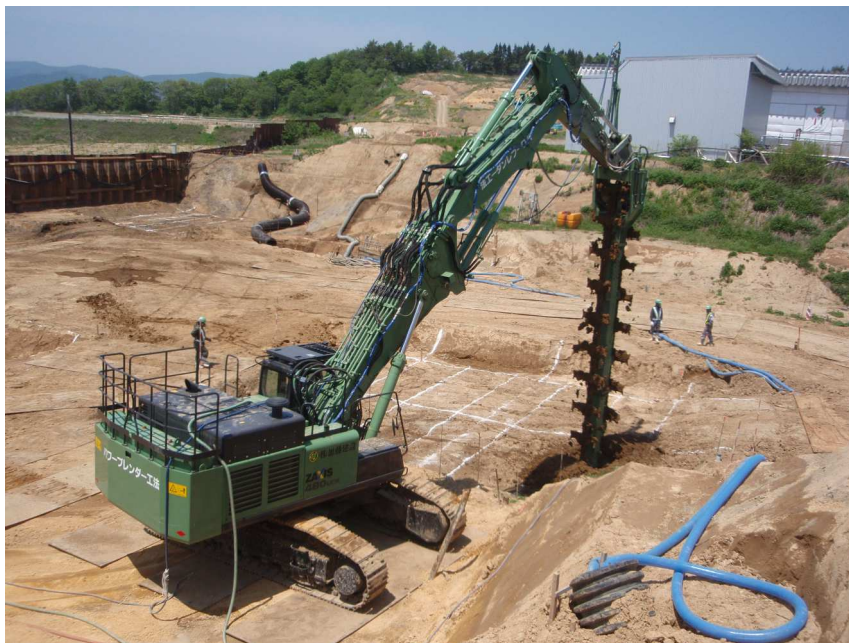
パワーブレンダーによるフェントン工の状況（5/24撮影）
