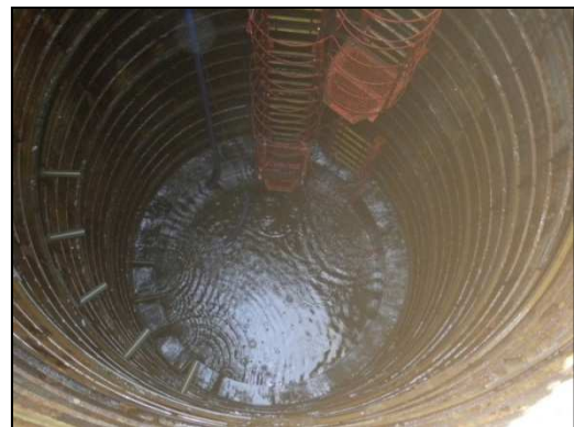
図8 横ボーリングによる地下水排水促進状況 (A地区での事例)
