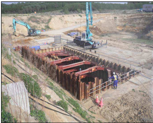
図7 土留め支保工による汚染土掘削除去 (N地区での事例)
