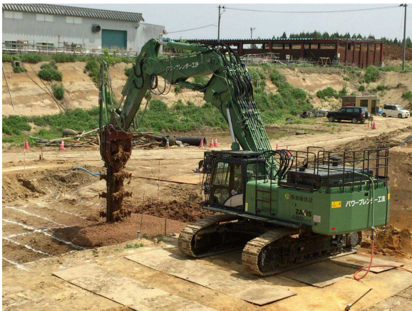
図2 土壌浄化状況
