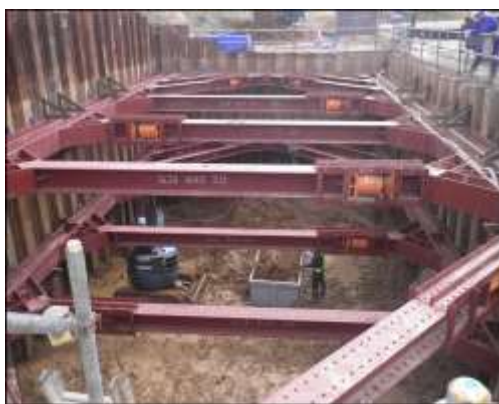
b-8、b-9区画の掘削状況
