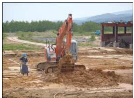
フェントン処理の状況
