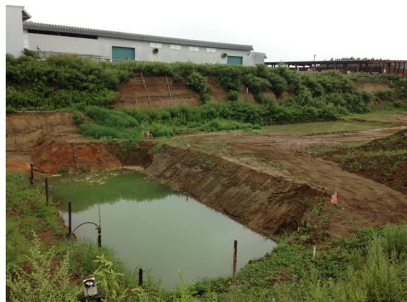
貯水池の設置状況
