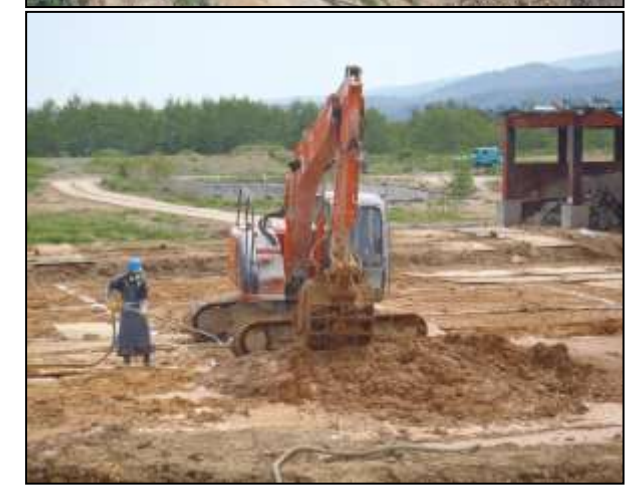
図 2-11 土留め支保工による掘削除去 +フェントン工
