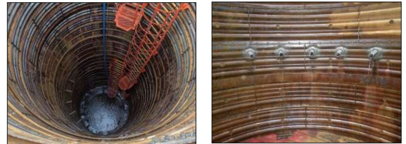
図 3-5 集水井+横ボーリング設置状況
