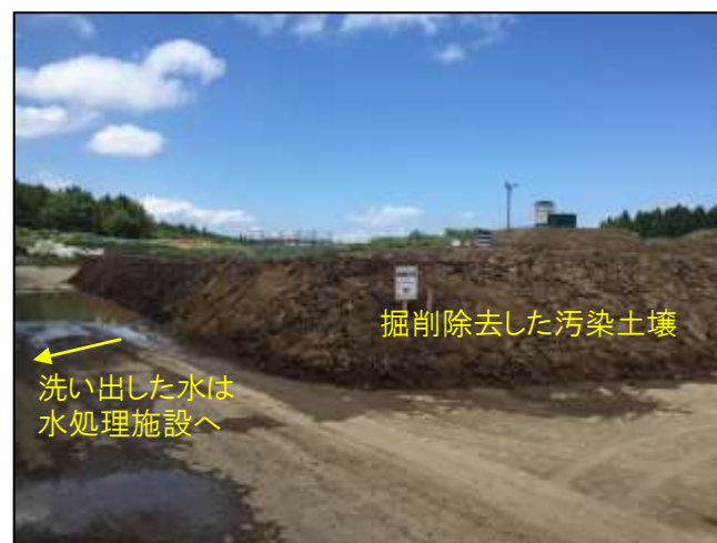
掘削土の洗い出し状況
