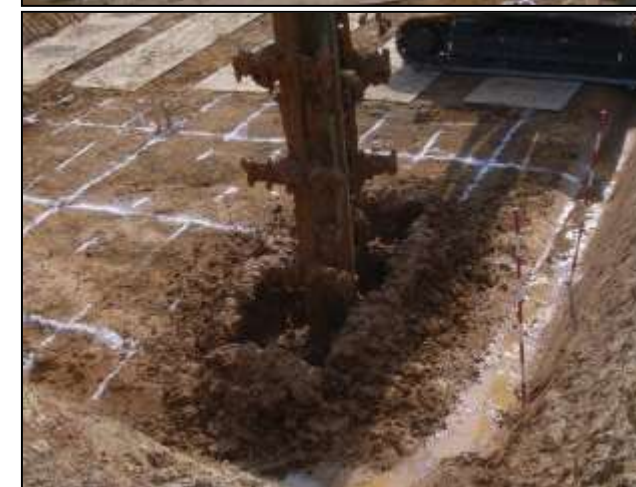
図 2-10 パワーブレンダーによる 原位置フェントン工
