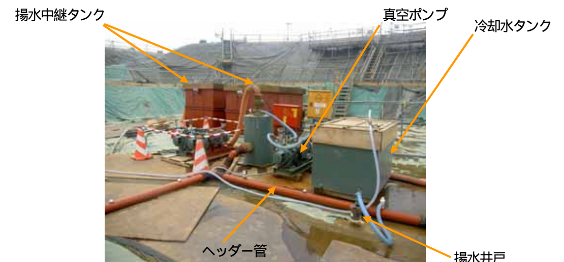
写真 - 2.1.2 揚水バッキ状況(真空ポンプ・中継タンク)
