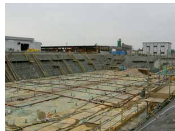
写真 - 2.1.1 加圧注入・揚水バッキ配管状況
