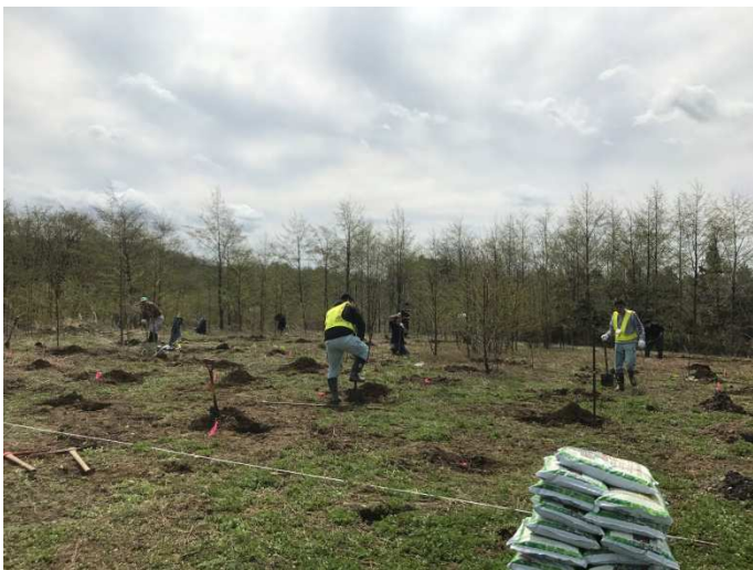
写真 植栽前の植穴掘り（左）と植栽（右）
