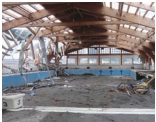
岩泉町立小本中学校の水泳プール(平成23年5月24日)
