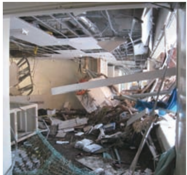
山田町立船越小学校の校舎内部(平成23年3月18日) 山田町教育委員会提供
