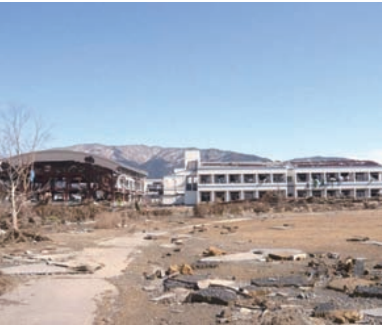
全壊した県立高田松原野外活動センター(平成23年3月19日)
