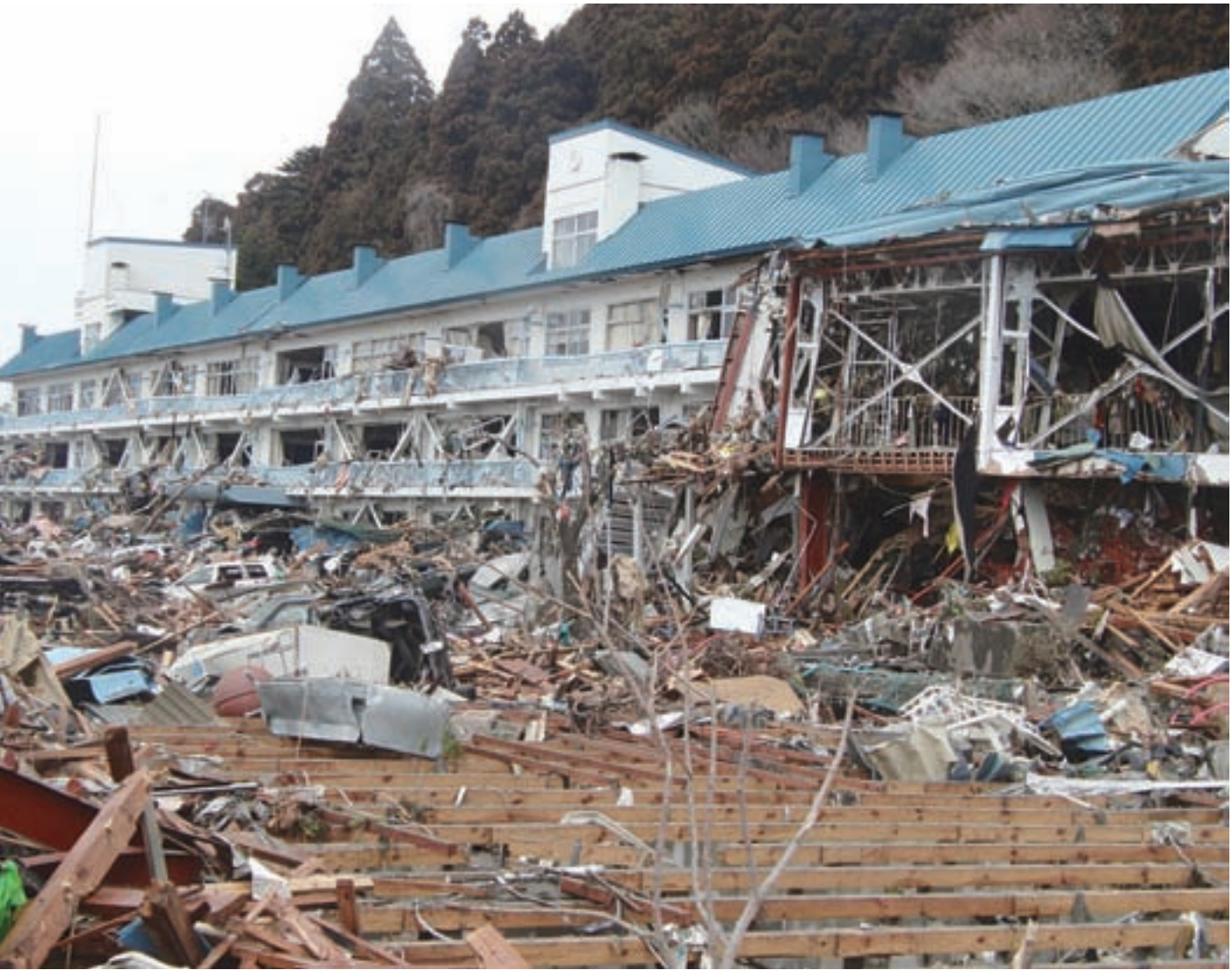
県立高田高等学校の校舎・校庭(平成23年3月16日) 同校提供
