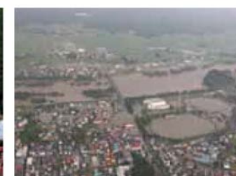
内水氾濫の被害
