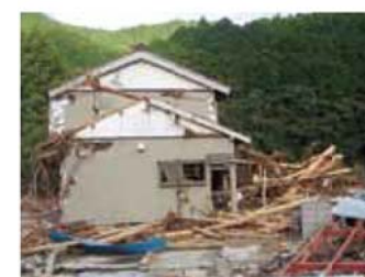
土石流の被害
