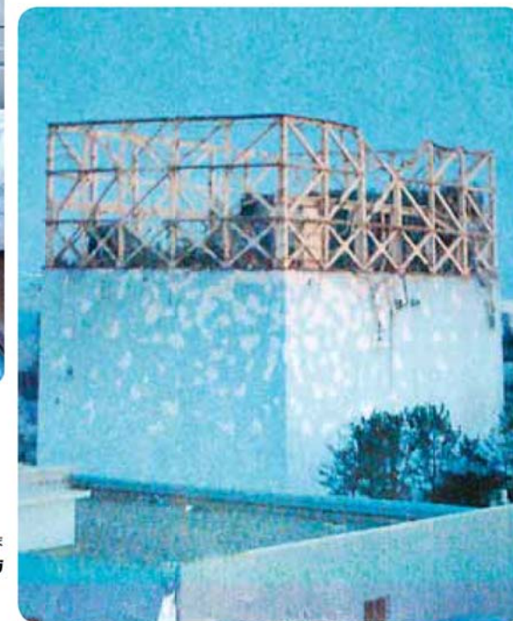
爆発で屋根とかべがこわれた福島第一原子力発電所の1号機
