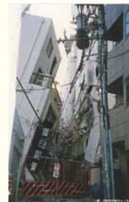
ビルの被害(阪神・淡路大震災)
