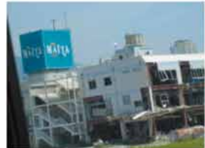
<3階まで破壊された建物>
