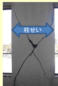
極短柱のせん断破壊
