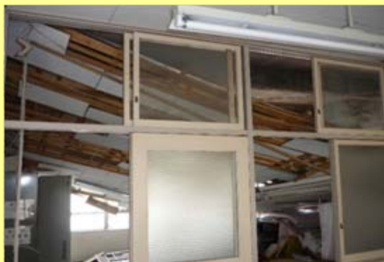
●地震により天井が崩落した教室
