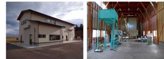
【整備したライスセンター】
