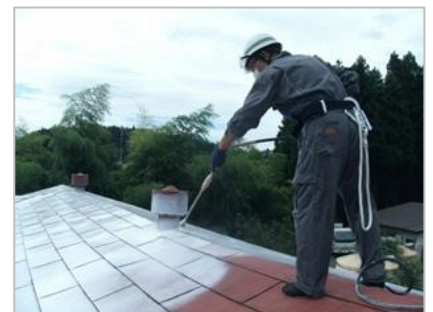
石灰の塗装風景
