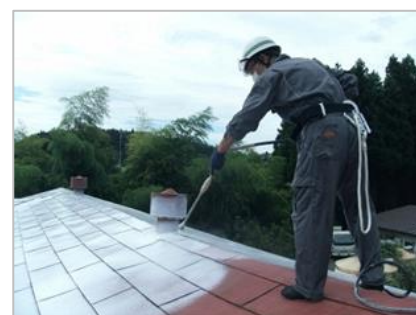
動力噴霧器による石灰塗装
