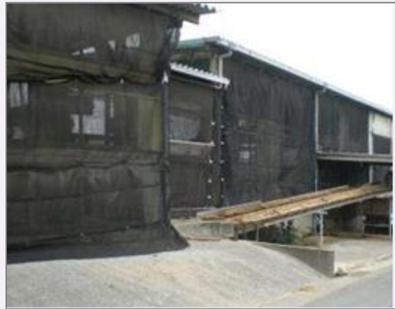
寒冷紗を設置した畜舎
