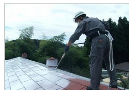
石灰の塗装風景
