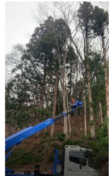
枯死木の伐採状況
