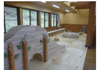
木製スペース設置
