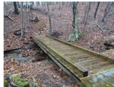
遊歩道整備(木橋)
