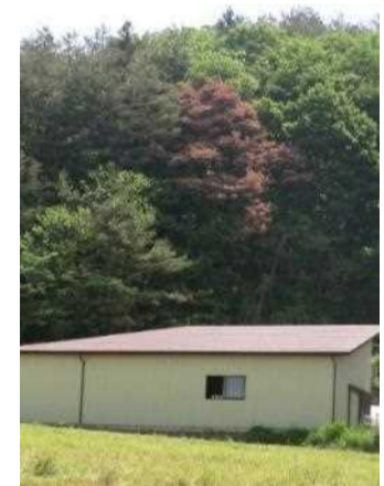
施設に隣接する枯死木
