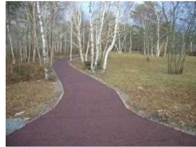
遊歩道のバリアフリー化(舗装)
