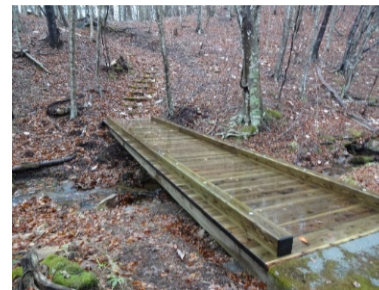
遊歩道整備(木橋)
