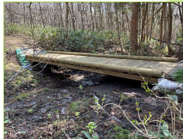
折爪岳森林公園（二戸市） 遊歩道整備（木橋）
