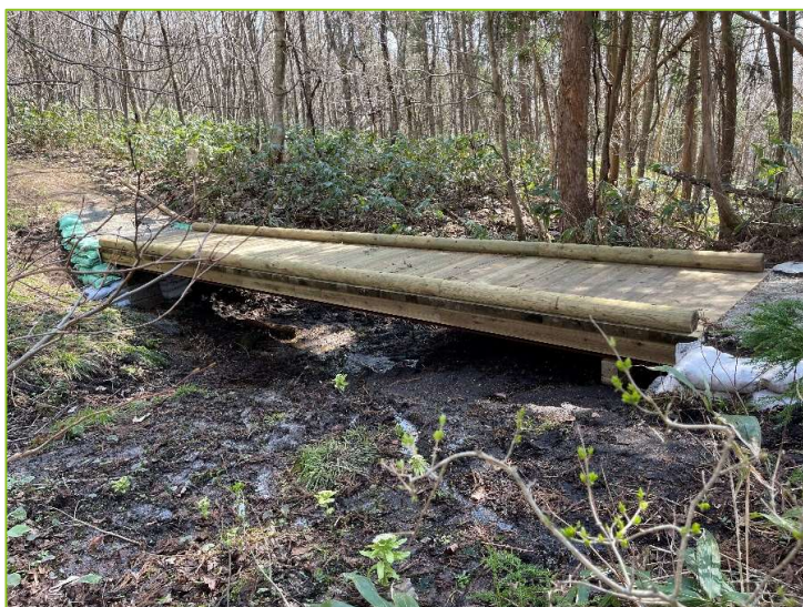
遊歩道整備（木橋）
