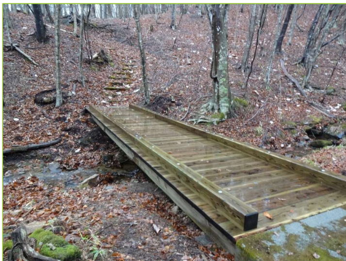
遊歩道整備（木橋）
