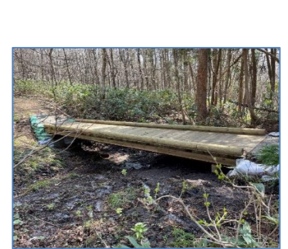
遊歩道整備 (木橋)
