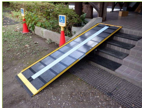
滝沢森林公園（滝沢市） 車いす用スロープ設置
