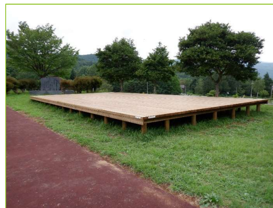
ウッドデッキ整備
