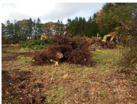
伐採作業の状況
