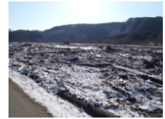
被災後の状況
