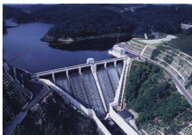
大志田ダム全景
