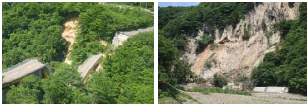
岩手・宮城内陸地震による被害状況
