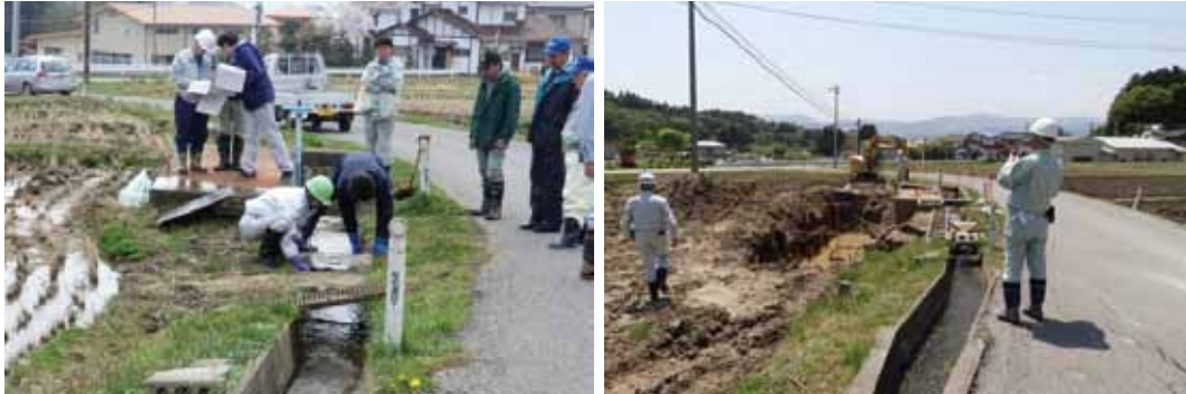
通水試験・被害調査の実施状況
