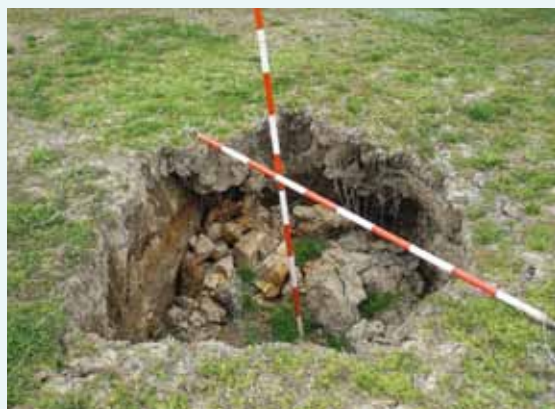
垂炭廃坑跡の陥没
