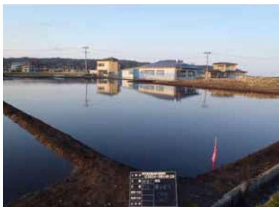
除塩（湛水・静置・排水）
