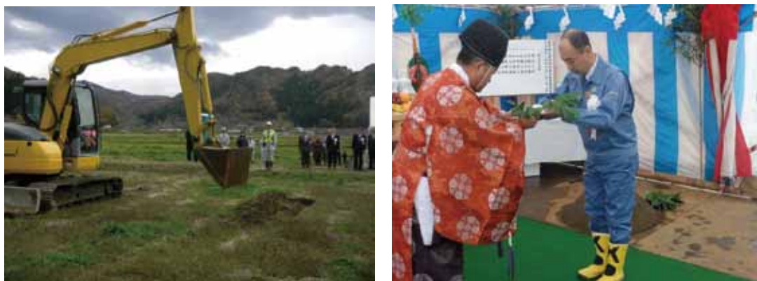
全国第1号となる摂待地区の起工式（右：三重県派遣職員の伊藤正幸さん）
