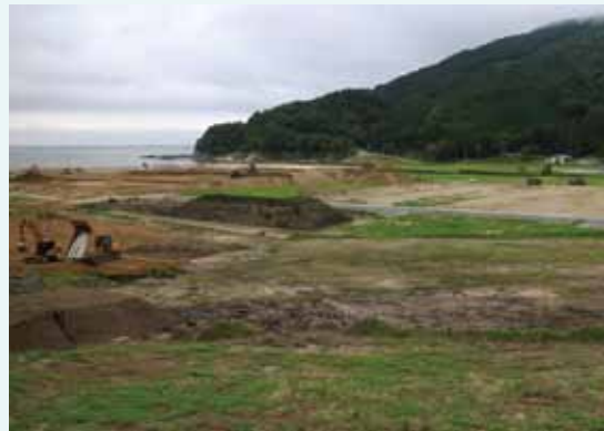
復旧工事（平成25年）
