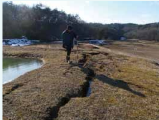
須川地区1号幹線用水路、一関市篠木沢新堤の被災状況
