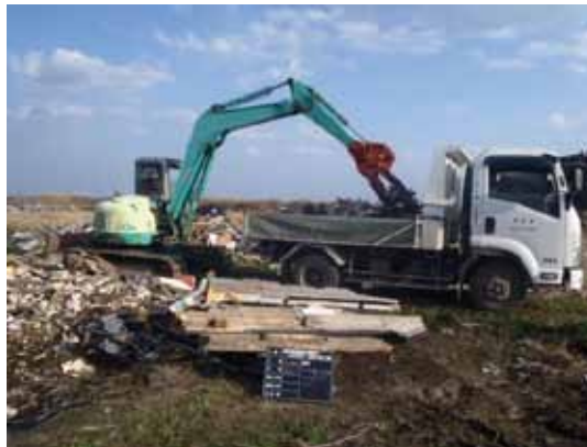
ガレキ撤去の状況（野田村）
