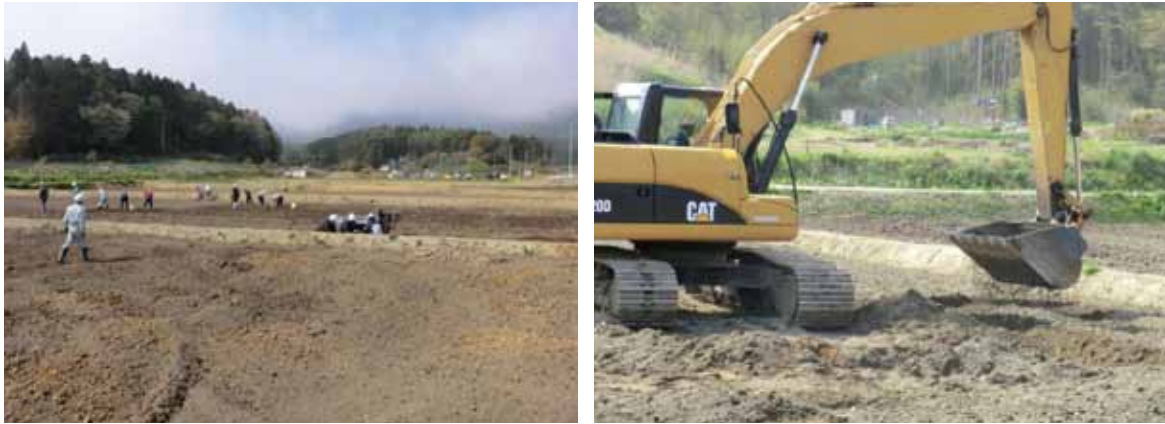
人力や機械による石礫除去作業
