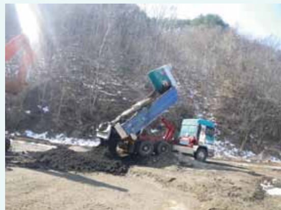
耕土搬入状況
