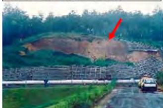
写真 37：堤体付近の法面(崩壊後)
