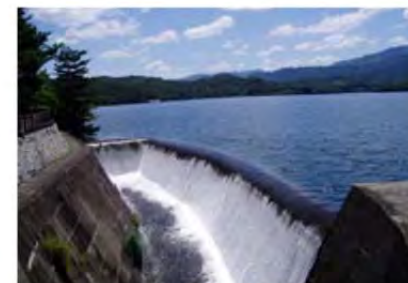
写真3：洪水吐 (香川県HPより)
