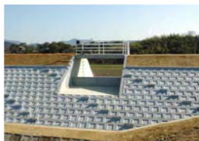
写真1：洪水吐 (香川県HPより)
