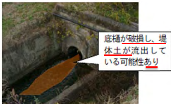
写真11：底樋出口（堤体下流）
