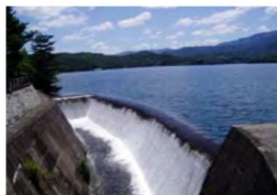
写真2：洪水吐 (香川県HPより)
