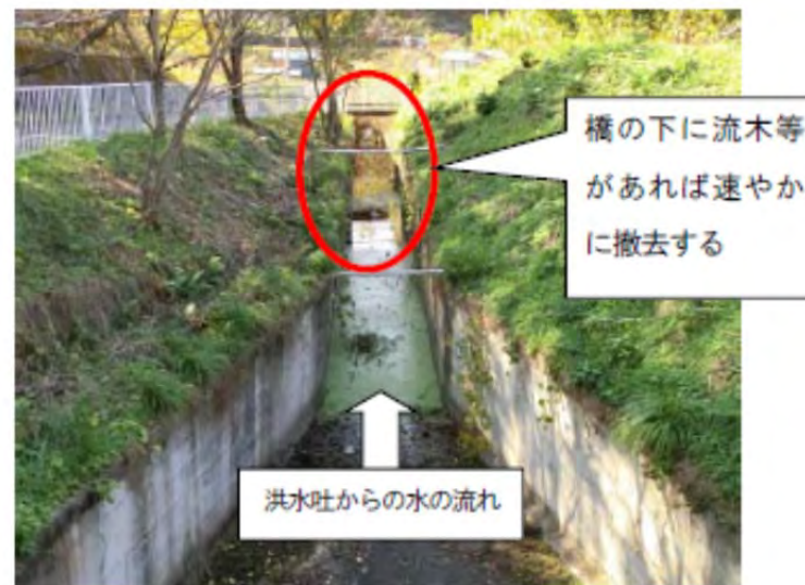
写真9：洪水吐下流水路の例
