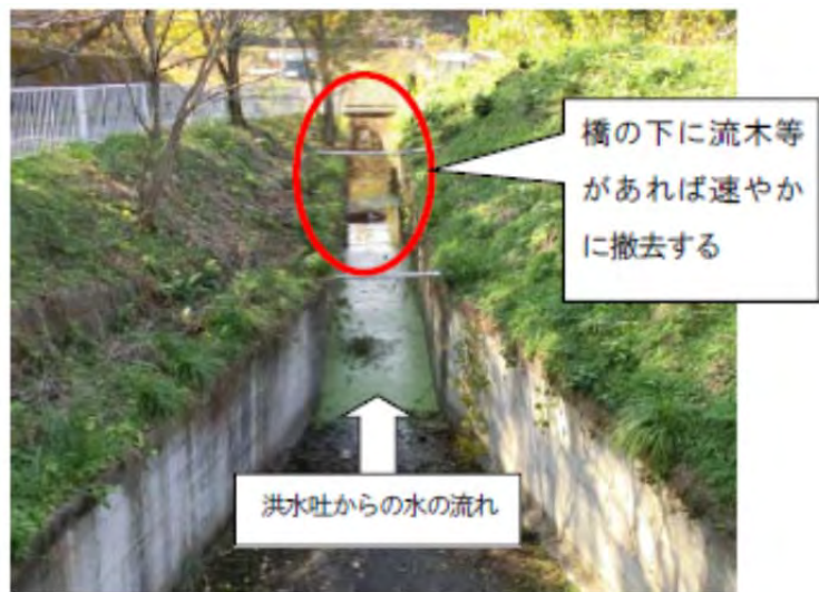
写真8：洪水吐下流水路の例
