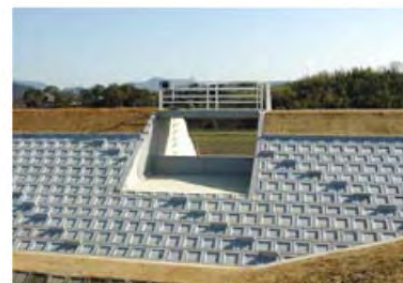
写真2：洪水吐 (香川県HPより)
