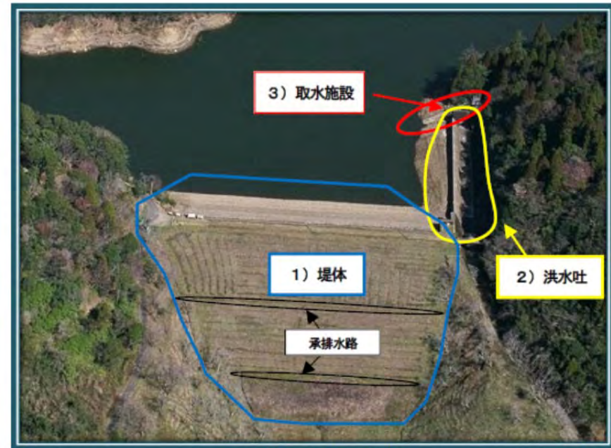
写真1：ため池の施設
