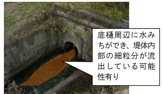
写真12：斜樋出口（堤体下流）
