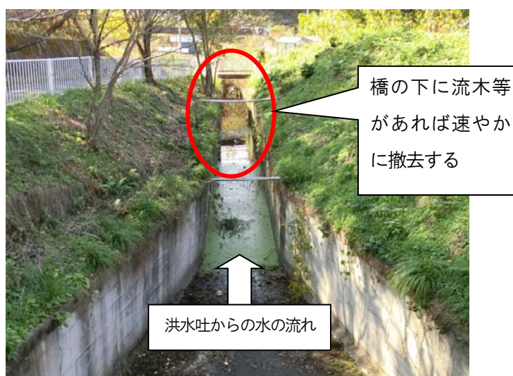
写真9：洪水吐下流水路の例
