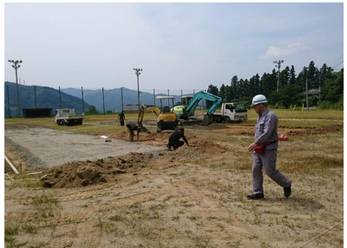
着工箇所における現場確認
