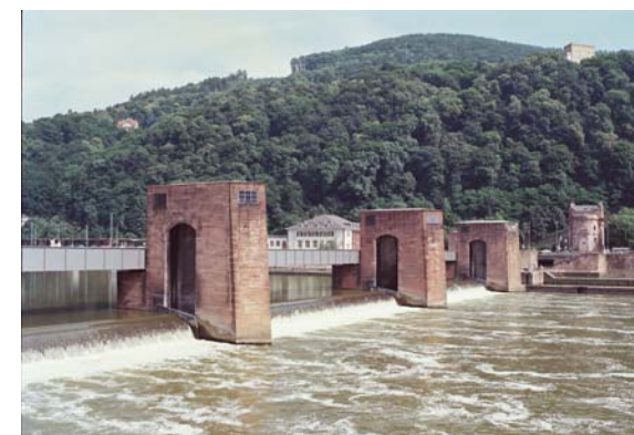
写真. ハイデルベルグネッカー川の堰・水閘門施設)
