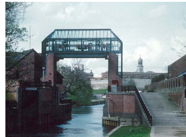
写真. 横転式格納ゲートを採用した例(ロンドン:市内運河の水門施設)
