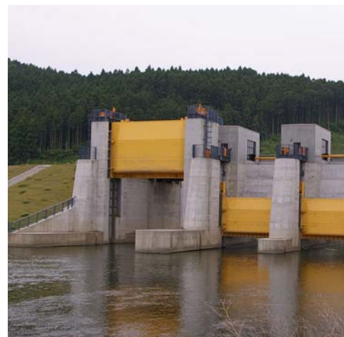
写真. 旧北上川、脇谷水閘門施設:通船部
