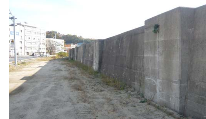
写真. 直立堤における縦リブの整備例(宮古市閉伊川)
