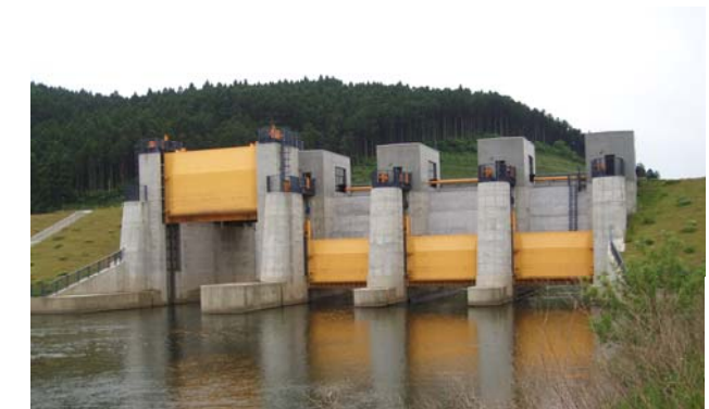
写真. 堤防との調和に配慮した水門の例② (旧北上川: 脇谷水閘門)
