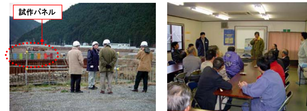
写真. 候補色を塗装したパネルを現地に設置し見え方を確認 確認後に地元の人たちと扉体の色について検討
