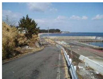
道路の被災状況
