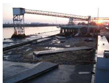
久慈港諏訪下地区（製氷工場付近）
