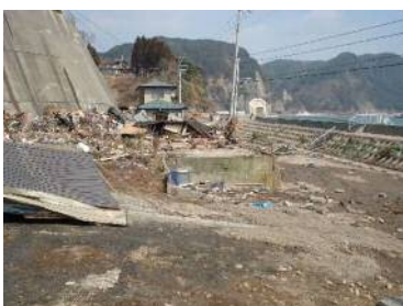
家屋の被災状況
