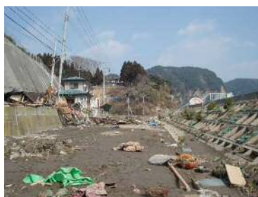
道路の被災状況
