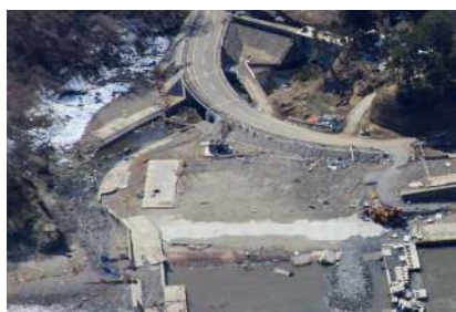
水門より下流側の被災状況
