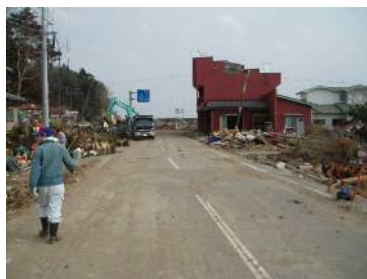
道路の被災状況
