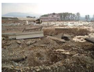
防潮堤背面の被災状況
