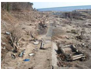
水門より下流側(左岸)の被災状況
