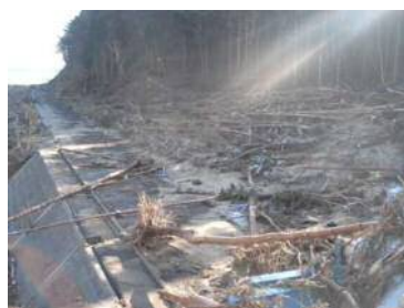
水門より下流側(右岸)の被災状況
