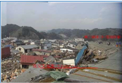
防潮堤背後の被災状況
