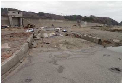
既存水門付近の被災状況
