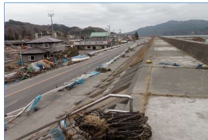
既存防潮堤背後の被災状況
