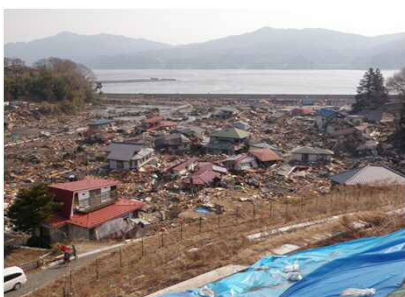
背後地の被災状況
