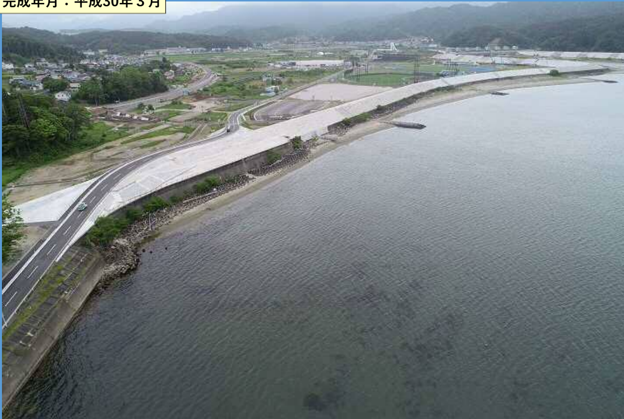
完成年月：平成30年3月
