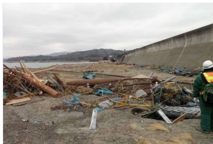
港湾内の被災状況
