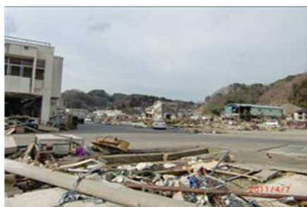
周辺家屋等の被災状況
