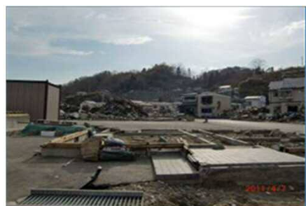
周辺家屋等の被災状況
