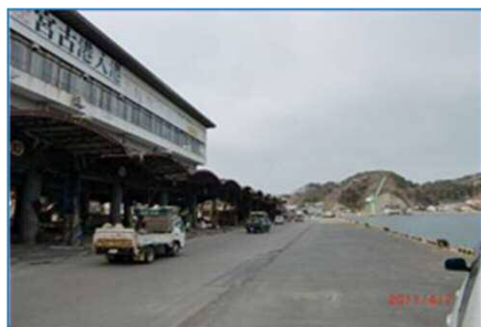
港湾内施設の被災状況
