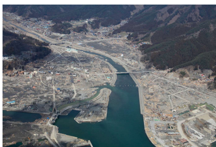
被災後の状況
