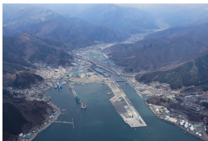
被災後の状況
