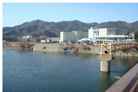
護岸損傷状況
