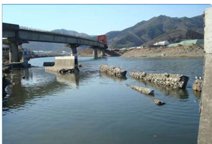
右岸側破堤状況
