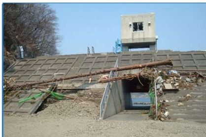
水海海岸防潮堤 左岸側
