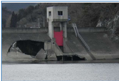
水海海岸防潮堤 海側
