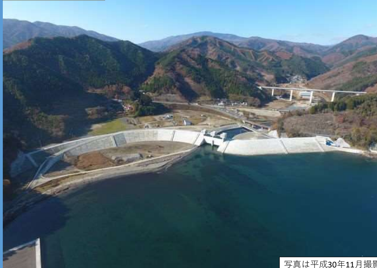
完成年月：平成30年3月
