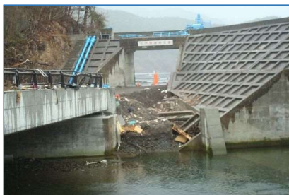
小白浜海岸防潮堤 左岸
