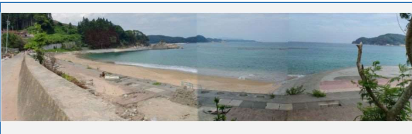
防潮堤 離岸堤
