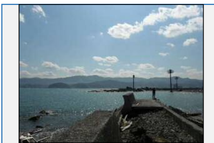
防潮堤 (浜田川付近から撮影)
