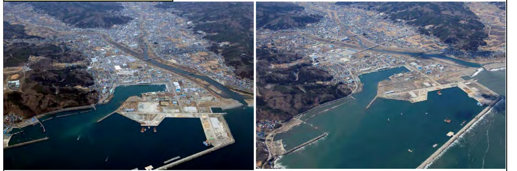
被災前状況 H22.3.24 撮影
